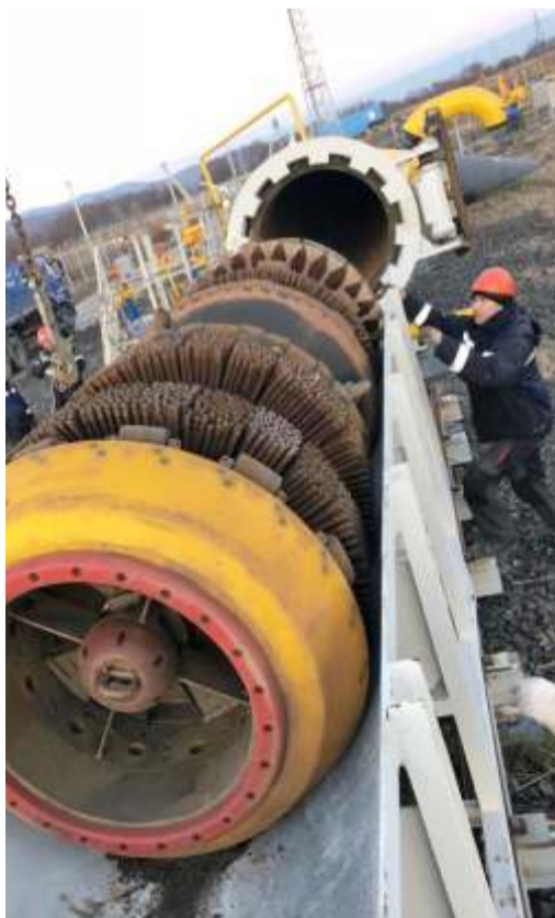
ВТД – это комплекс работ, обеспечивающий получение информации о дефектах, сварных швах, особенностях трубопровода и их местоположении
