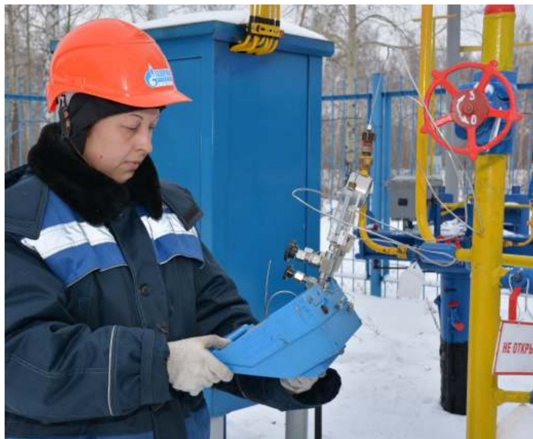
Проведение контроля качества газа (анализ точки росы) после завершения ремонтных работ на газопроводе Омск – Новосибирск – Кузбасс
